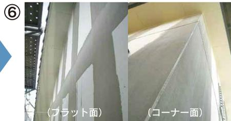
⑥ 下地処理完了。乾燥を確認後シーラー処理を行い、仕上げの準備に入ります。
