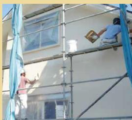
コテ等を用いて、お好みのテクスチャーに仕上げます。速乾性ですので、仕上げ塗りは最低2人以上のチームで各面ごとに素早く仕上げてください。
