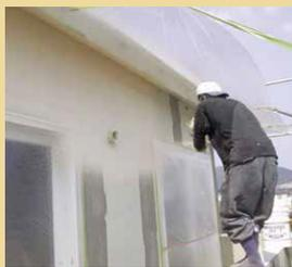
4～6mm口径のノズルで全面に吹付けを開始します。目地処理部分との境界部がフラットとなるように下吹きを行い、その後仕上げ吹きを行ってください。仕上げは各面ごとに仕上げてください。
