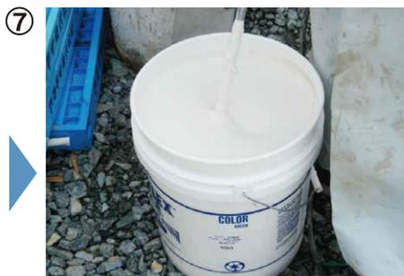
⑦ 仕上げ塗装の前にスタッコフレックスフィニッシュを攪拌機で十分に攪拌します。あらかじめ出荷時に粘度調整をしますが、施工ににくい場合は600cc/缶を目安に清水を各缶ごと一定量に加えながら、粘度の調整をしてください。
